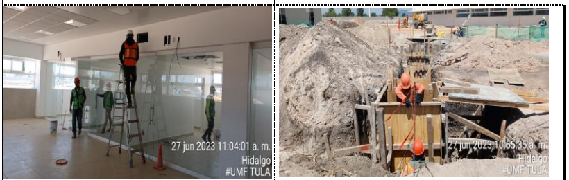
COLOCACION DE REGILLAS E INSTALACION DE CABLEADO PARA TV
