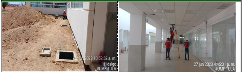
REGISTROS SANITARIOS, PLUVIALES, TUBERIA Y RELLENO
