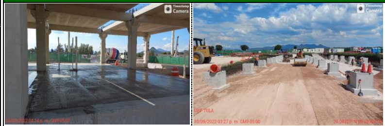
COLADO DE CONCRETO FLUIDO EN EDIFICIO PRINCIPAL, COLOCACION DE LOSAS ALVEOLARES, TRABES Y CONTRATRABES RELLENO CON MATERIAL DE BANCO COMPACTADO AL 90% DE SU PVSIM, ZAPATAS COLOCADAS EN SU TOTALIDAD
