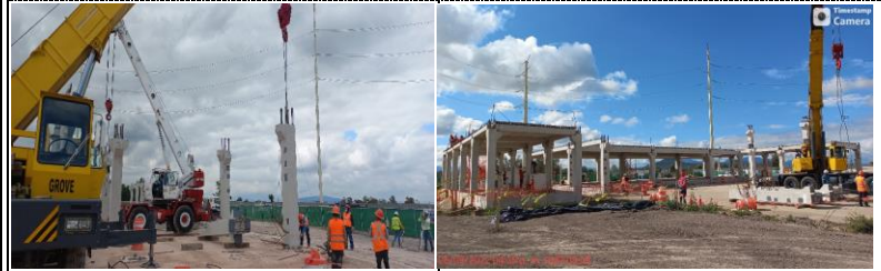
COLOCACION DE COLUMNAS DE CONCRETO PREFABRICADO LOSAS ALVEOLARES, COLUMNAS, TRABES, CONTRATRABES, ZAPATAS COLOCADAS, INICIO CON MURO HEBEL EN CASA DE MAQUINAS
