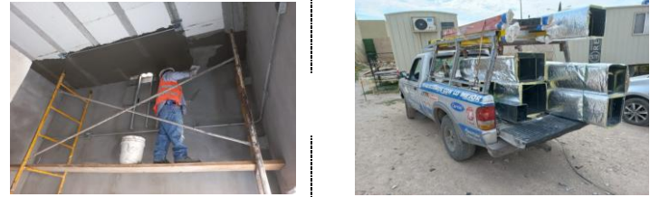
ejecucion del apianado fino de mezcla en el cielo de la losa de vigueta y bovedilla del area de la casa de maquinas. continuan suministrando y colocando ducteria
