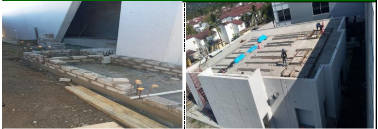
Fabricación de rampa de acceso en fachada principal, albañilería.
