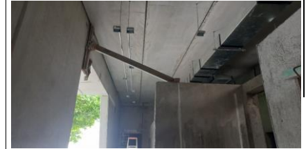
TRABAJOS DE INSTALACIÓN ELÉCTRICA
