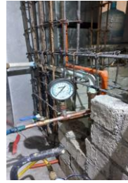
TRABAJOS DE INSTALACIÓN HIDRÁULICA
