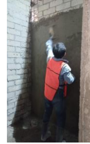
CONSTRUCCIÓN DE MUROS DE ALBAÑILERÍA Y APLANADO
