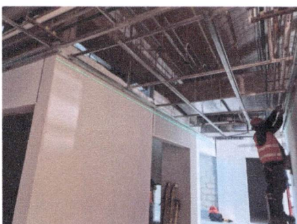
Colocación de bastidor para plafon en tococirugía N1
