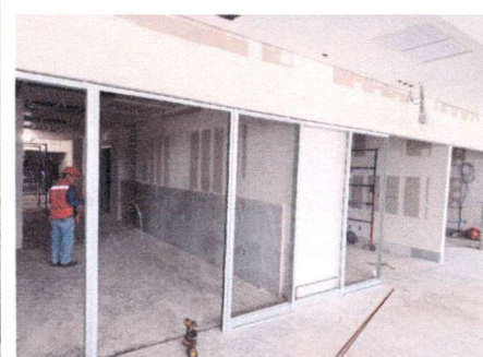
Colocación de cancel en sala de espera de quimioterapia N3
