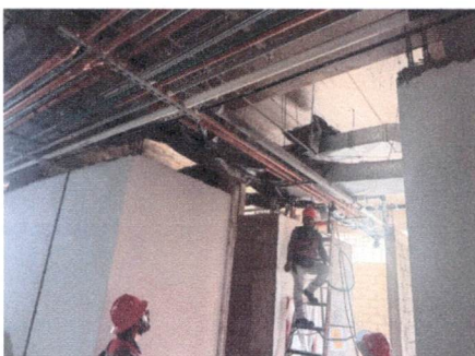
Instalación de tubería de cobre para cama hidráulica en área de cirugía N2
