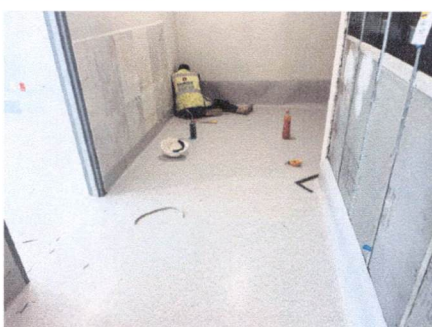
Colocación de vinil en area de hospitalización N3
