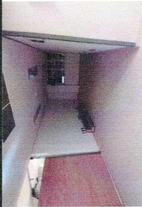
AVANCE EN CARPINTERIAS
