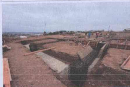
Aramdo de contratraves de cimentación.
