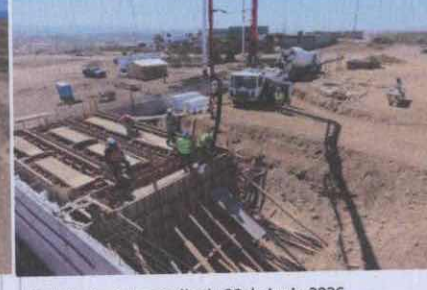
Colado de cisterna sábado 20 de junio 2026.
