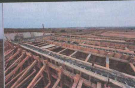
Descimbrado de cisterna muros interiores.
