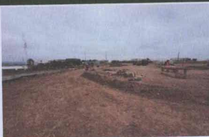
Relleno y compactación de cepas lado este.
