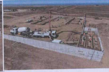
Colado de cisterna sábado 20 de junio 2026.
