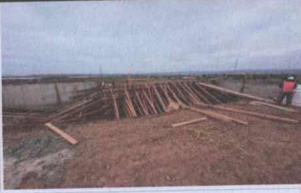
Descimbrado de cisterna.
