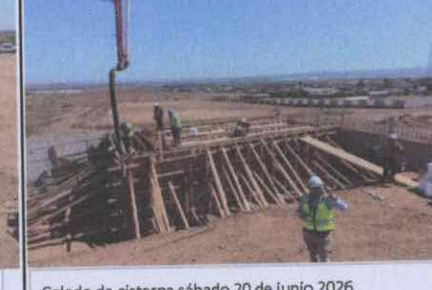
Colado de cisterna sábado 20 de junio 2026
