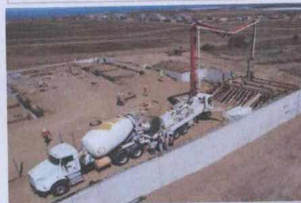
Colado de cisterna sábado 20 de junio 2026
