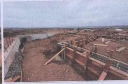
Continuidad con los trabajos de armados de cimentación.
