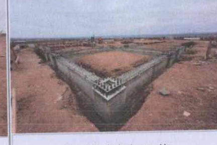
Descimbrado de cimentación.
