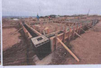
Colocación de anclas redondo liso en dados.
