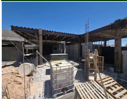
LEVANTAMIENTO MUROS CASA MAQUINAS
