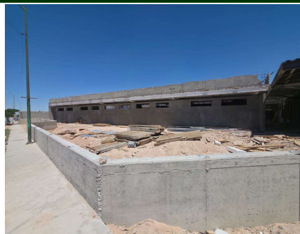
REPELLADO DE MUROS
