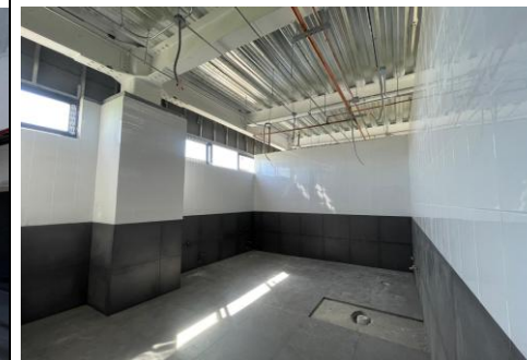
COLOCACION DE CERAMICOS
