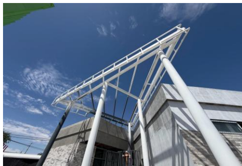
ESTRUCTURA DE CUBIERTA ACCESO PRINCIPAL
