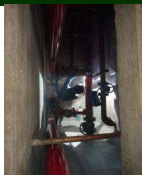
AREA DE CARCAMO SECO DE LA CISTERNA: EJECUCION DE REFUERZO DE SOPORTERIA DE TUBERIA HIDRAULICA
