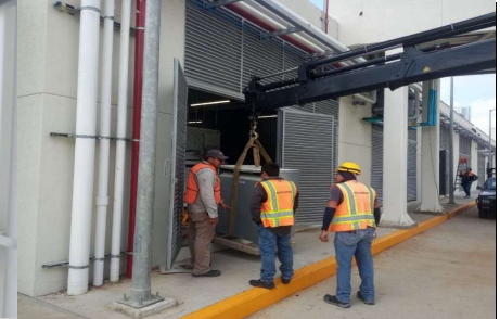
Acceso hacia observaciones menores en urgencias.
