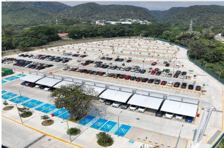
Limpieza fina del sitio de los trabajos
