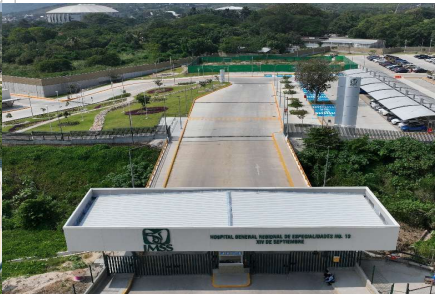
Colocación de señáletica en acceso principal
