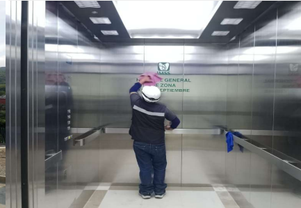
Limpieza fina de la obra.
