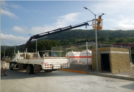
Sustitución de baterías de luminarias.
