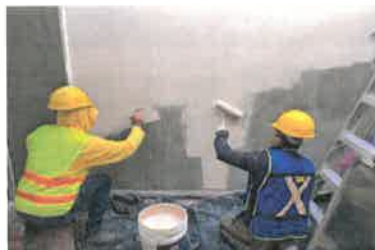
APLICACIÓN DE PINTURA EN MURO DE TERRAZAS DE CENTRAL NUEVA
