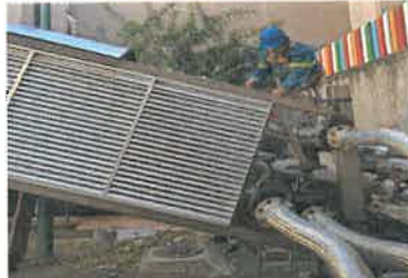
INSTALACIÓN DE CUBIERTA A BASE DE LÁMINA DE ACERO INOXIDABLE
