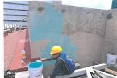
APLICACIÓN DE IMPERCOREV EN TERRAZA DE CENTRAL DE SERVICIOS
