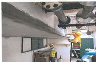
TRABAJO DE CAJILLO EN ÁREA DE ROPERÍA EN SÓTANO
