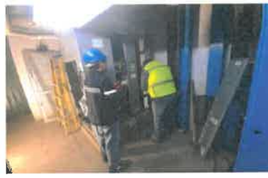
CONEXIÓN DE INTERRUPTORES EN EL TABLERO TGN-4C
