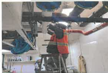
INSTALACIÓN DE FORRO EN TUBERÍAS DE AGUA
