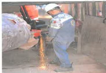
TRABAJOS DE SOLDADURA EN TANQUES DE DIÉSEL 1500
