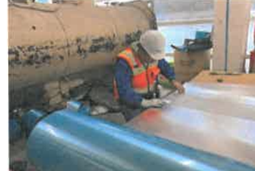
HABILITADO DE PROTECCIÓN METÁLICA EN CENTRAL
