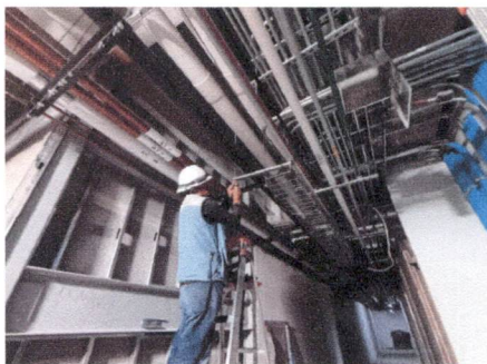
Colocación de cableado estructural en pasillo de cirugía N2
