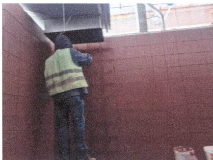
Colocación de loseta ceramica en área de nutrición y dietética PB
