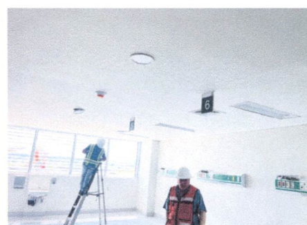
Colocación de señalética en hospitalización N3
