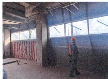
Colocación de hojas de durock en contrafachada de lavandería PB
