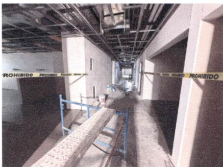
Colocación de autonivelante en área de hospitalización N2
