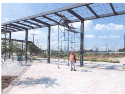
Aplicación de pintura esmalte para estructura de pasarela D
