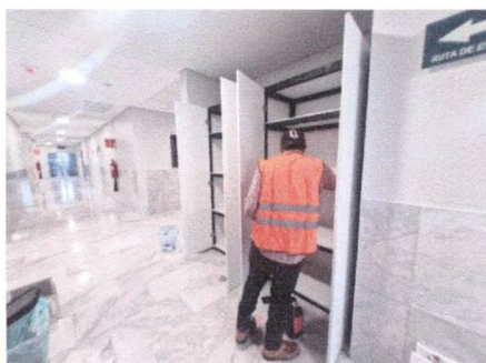
Trabajos en closet de ropa limpia en medicina fisica Pb
