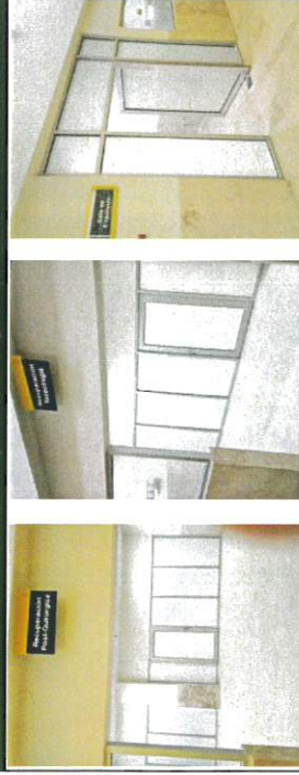
Instalación de película de esmerilado en las áreas de Recuperación
