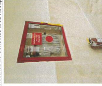
Coneccion electrica de Consolas area Recuperacion
