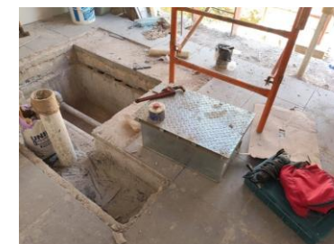
Colocación de trampa de grasa sanitaria.
