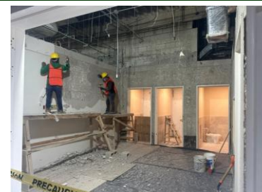
Retiro de aplanado baritado dañado.
