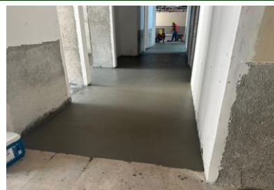
Colado de sobrefirmes.
