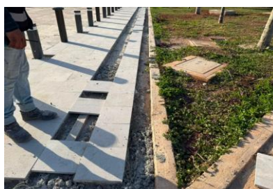
Colocación de piedra de la región en banquetas.
