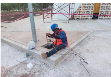
Cableado de luminarias obra exterior.r
