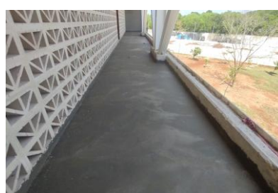
Impermeabilizante en terraza.
