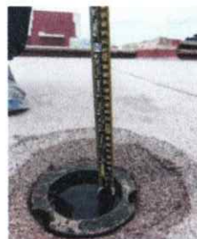
Pruebas de línea sanitaria
