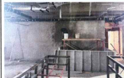
Acabados de muros falsos de tablaroca y durock
