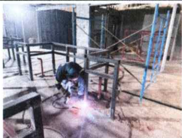
Trabajos de herrería N3
