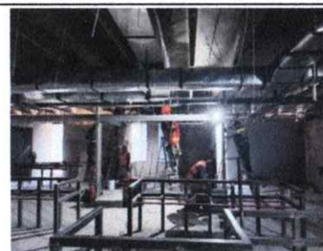
Trabajos de aire acondicionado
