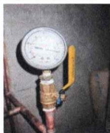
Prueba de línea hidráulica
