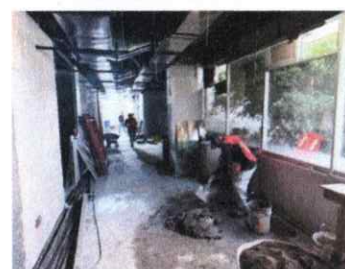
Trabajos de albañilería nivel 3
