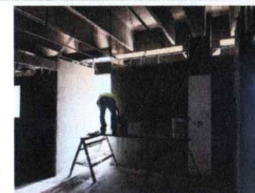
Trabajos de acabado de muros falsos de tablaroca y
