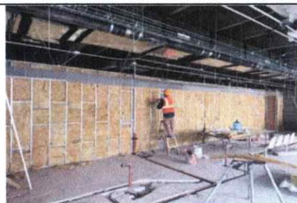
Instalación de fibra acústica
