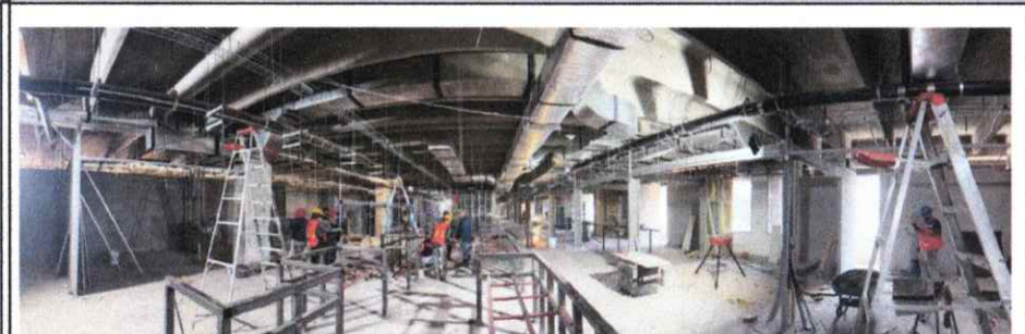
VISTA PANORAMICA PLANTA N-3
