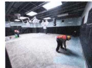
Trabajos de albañilería nivel 2 (sala de cirugía 1)
