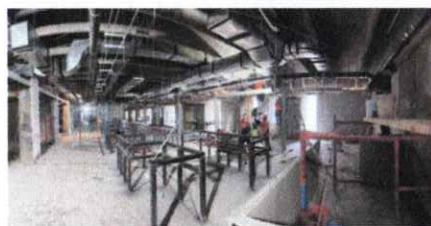
Trabajos de herrería N3 y A.A. (central de enfermeras)
