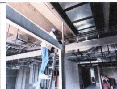
Trabajos de electricidad nivel 3 (charofill)
