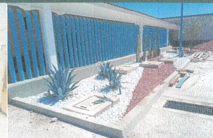
Avance de trabajos de cubresuelos en area exterior de
