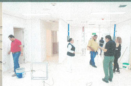
Supervisión de trabajos en CEYE. Área de eserilizadores,
