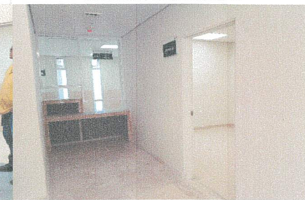
Avance de los trabajos en área de recepción de muestras y acceso a ultrasonido. Edificio 4.
