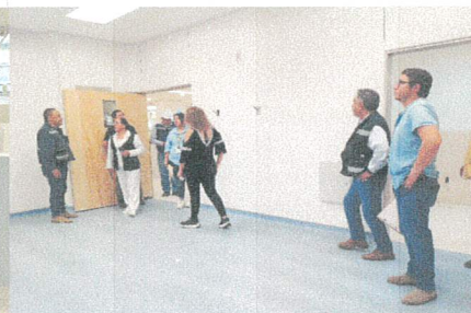
Supervisión de los trabajos en sala de expulsión. Edificio 4.
