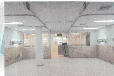
Avances de trabajos en área de recuperación de tococirugia y cirugia. Edificio 4.
