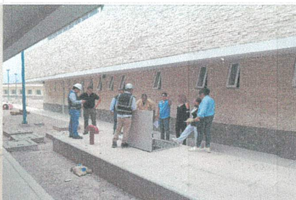
Supervisión de trabajos de cisterna de reuso. Área exterior edificio 1.
