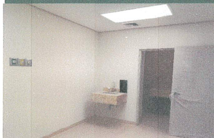
Avances de trabajos en área de ultrasonido . Edificio 4
