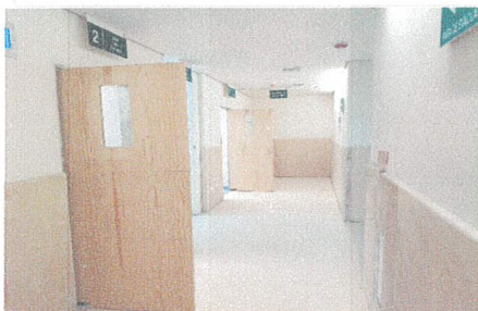
Avance de trabajos en vestibulo y accesos a salas de
