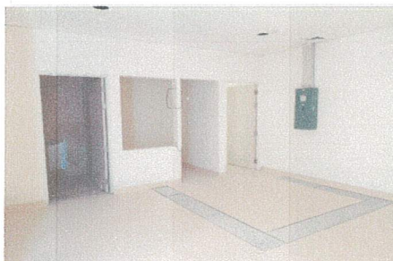
Avances de trabajos en área de rayos X. Edificio 4.
