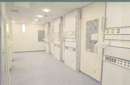
Avances de trabajos en área de UCEN. Edificio 2
