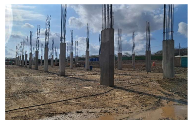
Trabajos de colado y descimbrado de columnas del Edificio "E".
