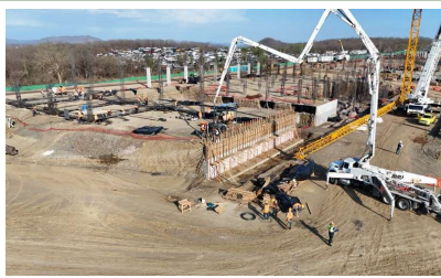
Trabajos de colado de muro de contención del edificio "A".
