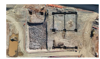
Trabajos de excavaciones para cimentación en edificio "G"
