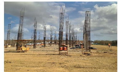
Trabajos de habilitado de acero de refuerzo para columnas del edificio "C".
