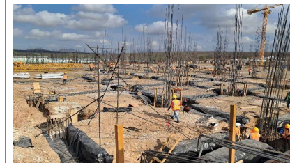
Trabajos de excavaciones y habilitado de acero para trabes
