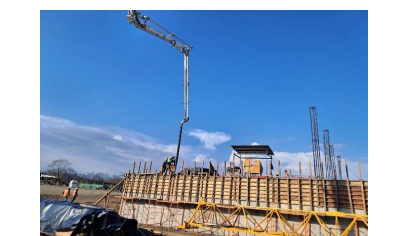
Trabajos de colado de muro de contención del edificio "F".
