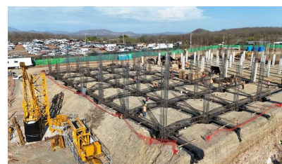
Trabajos de habilitado de acero para trabes y dados y columnas del edificio "D1".
