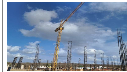
Trabajos de colocación de torre grúa.
