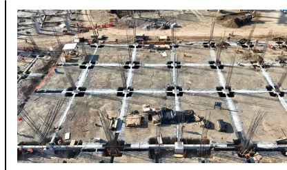
Trabajos de colado de trabes de liga y dados de cimentación del edificio "F".
