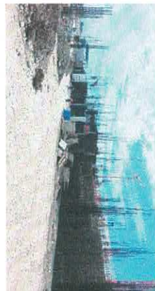
Inicio de colocación de apuntalamiento en edificio "A" colocación de puntales y vigas madre para fondos de trabes.
