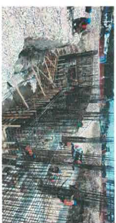
Continuación de suministro y habilitado de acero para cimentación de edificio "H"
