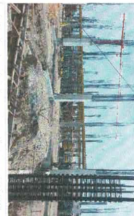
Inicio de colocación de apuntalamiento en edificio "A" colocación de puntales y vigas madre para fondos de trabes.
