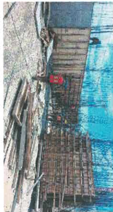
Seguimiento de construcción de suministro y habilitado de acero para muro de contención en edificio "D"
