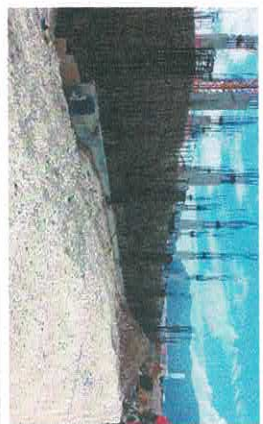
Seguimiento de construcción de suministro y habilitado de acero para muro de contención en edificio "D"
