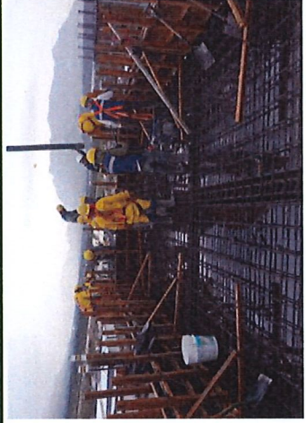
COLADO DE LOSA NIVEL 25.35 EN EDIFICIO DE TANQUE DE DIESEL
