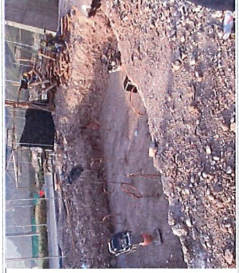
COMPACTACION EN AREA DE CASETA RECEPTORA
