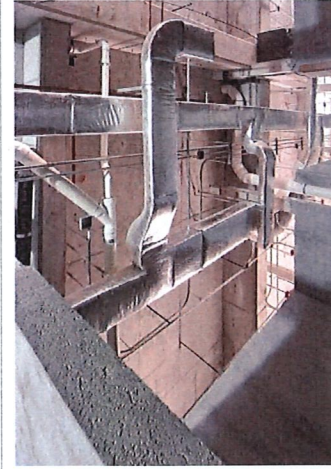
INSTALACION DE DUCTERIA DE AIRE ACONDICIONADO EN EDIFICIO D
