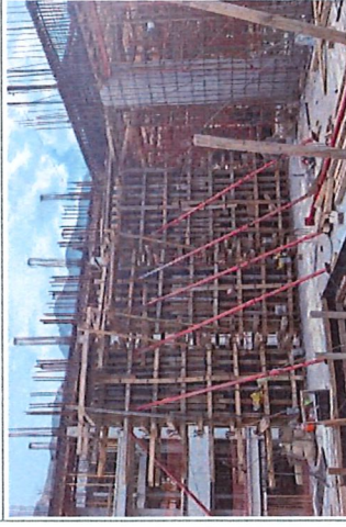
COLADO DE LOSA NIVEL 25.35 EN EDIFICIO DE TANQUE DE DIESEL
