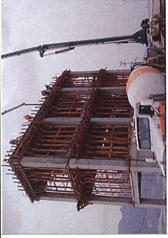
COLADO DE LOSA NIVEL 25.35 EN EDIFICIO DE TANQUE DE DIESEL
