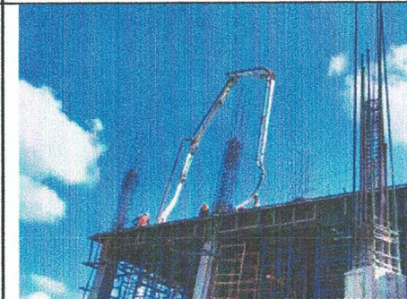
COLADO DE PRETIL EN LOSA DE AZOTEA EDIF. "A"
