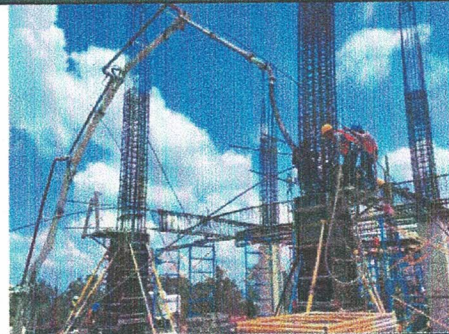
COLADO DE COLUMNAS N-2 EDIF. "B"
