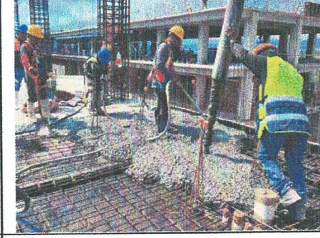
COLADO DE LOSA N-2 EDIF. "B"
