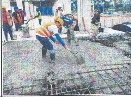
COLADO DE LOSA PB EDIF. "D"
