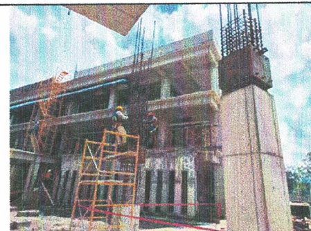
COLOCACIÓN DE PLACAS DE ACERO EN COLUMNAS PB VESTÍBULO
