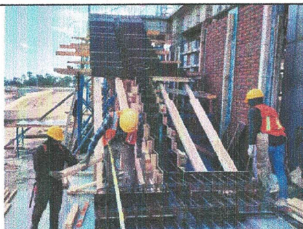
COLOCACIÓN DE CIMBRA EN ESCALERA DE SERVICIO PB EDIF. "B"
