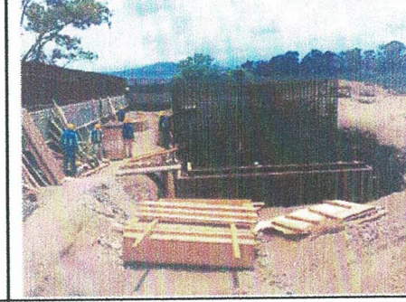
CIMBRA EN PLANTA DE TRATAMIENTO PARA AGUAS RESIDUALES
