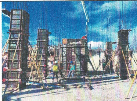
COLADO DE COLUMNAS PB EDIF. "C"
