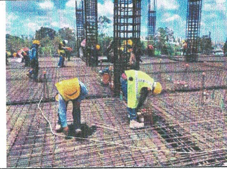
ARMADO DE PARRILLA EN LOSA N-2 EDIF. "B"
