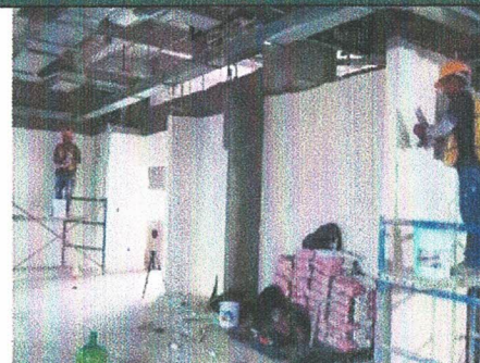
AFINE EN MURO PBEDIF. "A"
