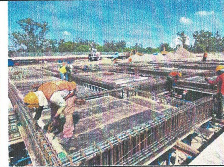
HABILITADO DE ACERO EN TRABES PB EDIF. "D"
