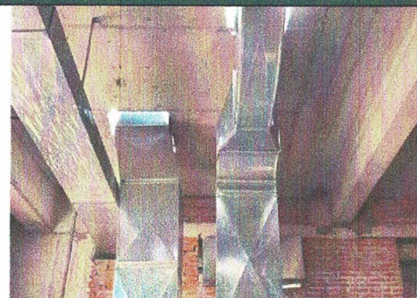
COLOCACIÓN DE DUCTERÍA EN CUARTO DE MÁQUINAS PBEDIF. "A"
