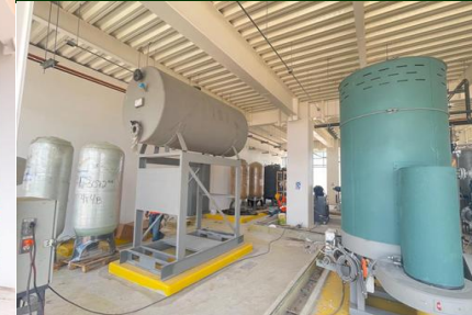
Colocación de Calderas, Tanques de Condensado y
