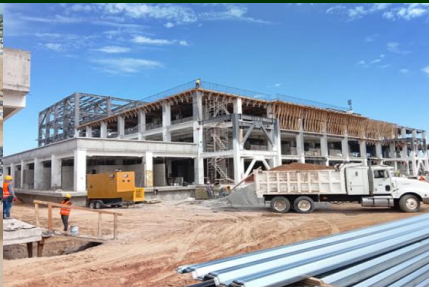
Albañilerías y Pintura Intumescente en Cuerpo Principal.
