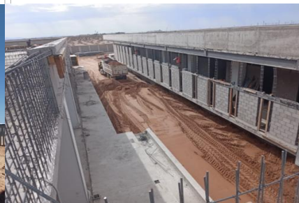
Rellenos en Obra Exterior.
