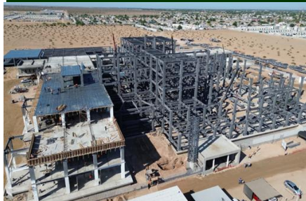
Montaje de estructura metálica, losacero y entrepisos en
