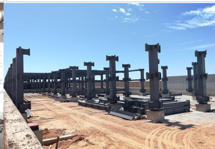
Montaje de Estructura Metálica en Cuerpo de Estacionamiento.
