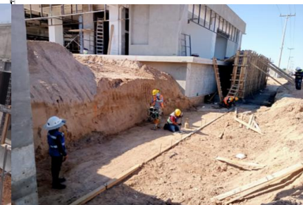
Cierre en Bardas Perimetrales en Obra Exterior.
