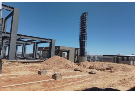
Cimentación Puente Peatonal y Estela Institucional en
