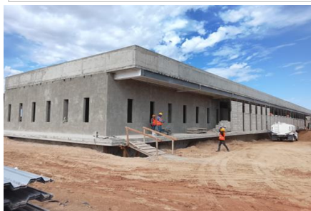
Albañilería y Fachadas en Cuerpo de Servicios Generales.
