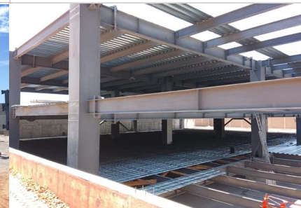
Colocación de Losacero en Cuerpo de Estacionamiento.
