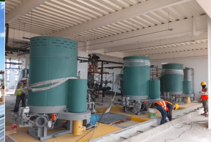
Acabados y Colocación de Calderas en el Cuerpo de Casa
