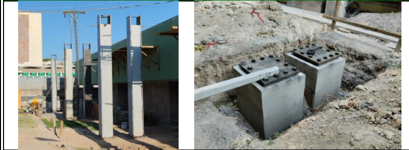
Columnas de Acero principales
