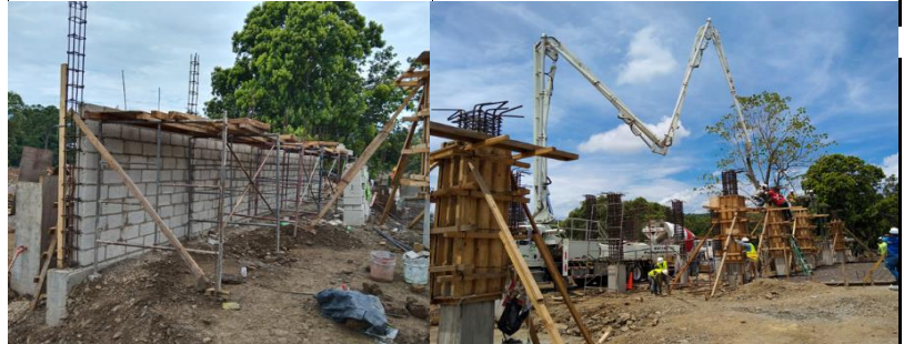
CONSTRUCCIÓN DE BARDIA PERIMETRAL A BASE DE BLOCOS LIGEROS DE 20*15*40 CMS CON REFUERZO HORIZONTAL, VERTICAL CASTILLOS KI Y DALA DE CERRAMIENTO
