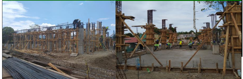
CIMBRA PARA TRABES EN EJE H PLATAFORMA 10
