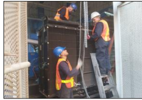
EN EJECUCIÓN EL SERVICIO DE MANTENIMIENTO PREVIO AL ARRANQUE DE PLANTAS DE EMERGENCIA DE 800 KW.
