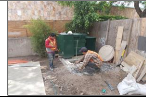
SUMINISTRO Y COLOCACIÓN DE TRANSFORMADOR DE 500 KVA, 23000-220 V EN REGISTRO DE MEDIA TENSIÓN PARA CENTRO DE MEZCLAS.
