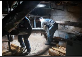
DESMONTAJE DE TUBERÍA EXISTENTE Y OBRA DE FUNCIONAMIENTO EN SÓTANO Y DUCTO DE INSTALACIONES DEL HOSPITAL GENERAL PARA PROYECTAR LA TRAYECTORIA DE LAS TUBERÍAS CON LAS CUALES SE EJECUTARÁN LAS INTERCONEXIONES.
