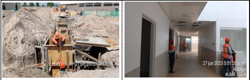
CIMBRADO DE REGISTRO EN BIODIGESTOR
