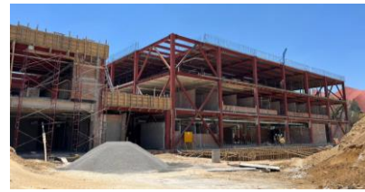
Avance en edificio principal.
