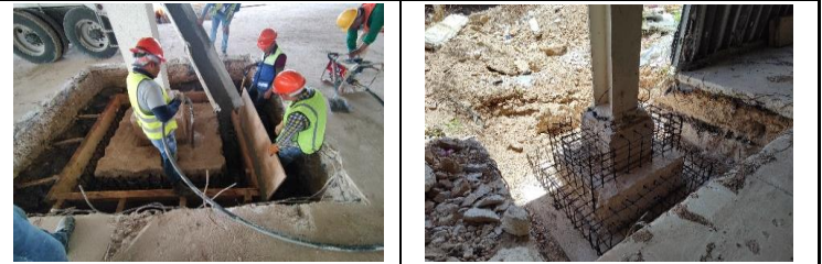
COLADO DE AMPLIACION DE ZAPATAS TRABAJOS DE RECIMENTACIÓN
