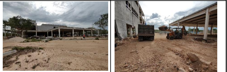
RETIRO DE FACHADA DE DUROCK EXISTENTE
