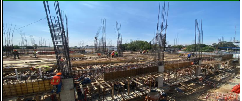
VISTA PANORAMICA DEL AREA CIMBRADO PARA LOSA DE ENTREPISO DE 1 ER NIVEL TRAMO (5-9) ENTRE ((C-G))
