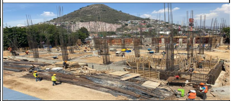
TRABAJOS DE CIMBRADO DE MADERA EN CONTRATABES DEL TRAMO (1-2) ENTRE (A-B)
