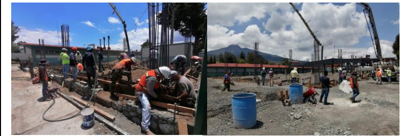
Habilitado de Acero, Cimbra y Concreto en Cimentacion de Cuarto Electrico.
