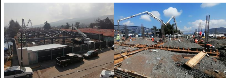
Habilitado de Cimbra, Acero de refuerzo en cimentación y montaje de estructura en Albergue.
