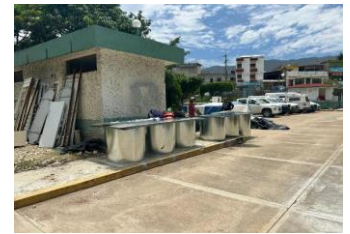
HABILITADO DE DUCTERIA DE AA
