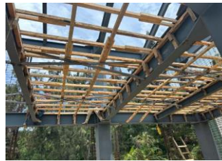
CIMBRA EN LOSA DE ENTREPISO
