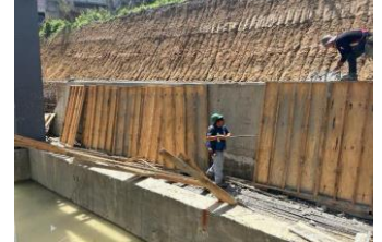
COLADO EN MURO DE CONTENCIÓN
