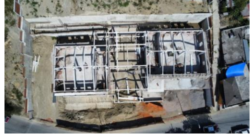
VISTA AZOTEA ESTRUCTURA METALICA Y MUROS PERIMETRALES
