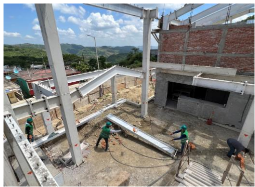
SUMINSITRO DE TABIQUE Y ESTRUCTURA
