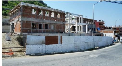
VISTA FRONTAL LATERAL TAPIALES Y MURO DE CONTENCION
