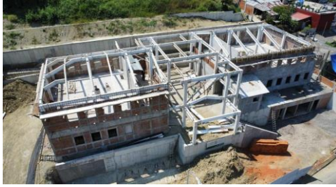
VISTA FRONTAL Y AZOTEA ESTRUCTURA Y ALBAÑILERIAS
