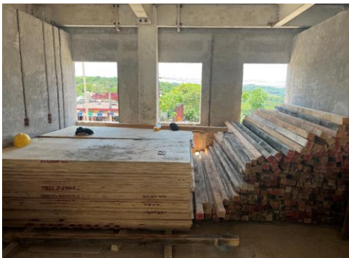
SUMINISTRO EXISTENTE DE MADERA PARA CIMBRA
