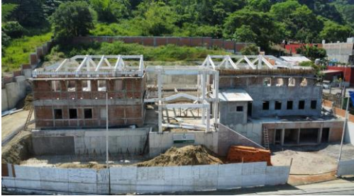
VOSTA FRONTAL ALBAÑILERIAS
