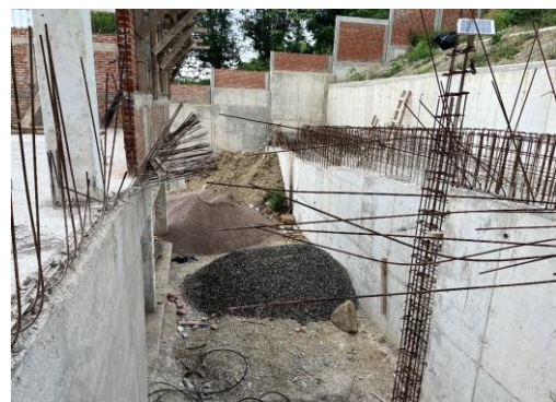
SUMINISTRO DE MATERIAL DE AGREGADOS
