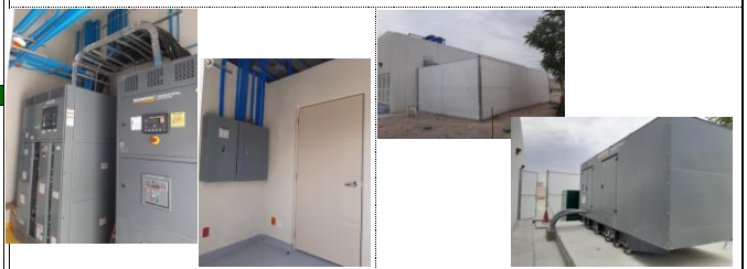
EJECUCION DE LA APLICACION DE LA PINTURA AZUL PANTONE EN AREA DE CASA DE MAQUINAS SUMINISTRO Y COLOCACION DE LA MALLA CICLONICA PARA PROTECCION Y SEGURIDAD DE LA PLANTA DE EMERGENCIA Y DEL TRANSFORMADOR
