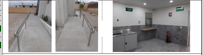
SUMINISTRO Y COLOCACION DE LOS PASAMANOS DE ACERO INOXIDABLE DE LA RAMPA DEL ACCESO PRINCIPAL Y DEL ACCESO AL RPBI SUMINISTRO Y COLOCACION DE 8 EXTINTORES EN DIFERENTES AREAS DEL EDIFICIO
