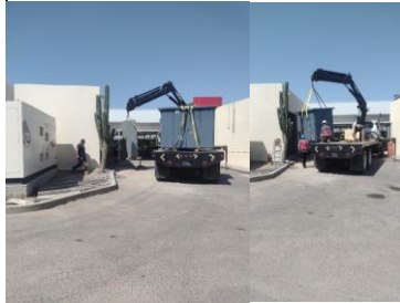
maniobras para montaje de equipo electrico
