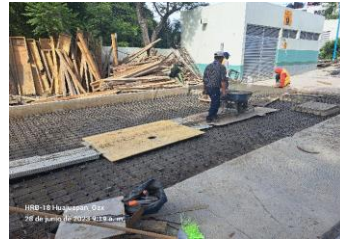
Armado y colado de vialidad de acceso a urgencias
