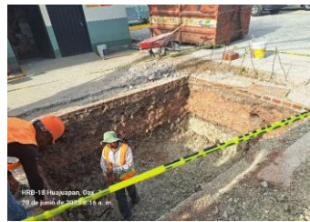
Excavación para cisterna pluvial
