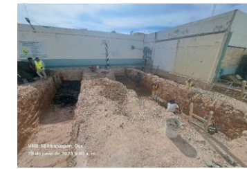
Excavación, compactación, relleno y colado de plantillas en cepas para cimentación de Comedor
