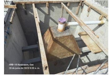
Suministro de tecnología y colocación de cimbra en losa tapa de PTAR
