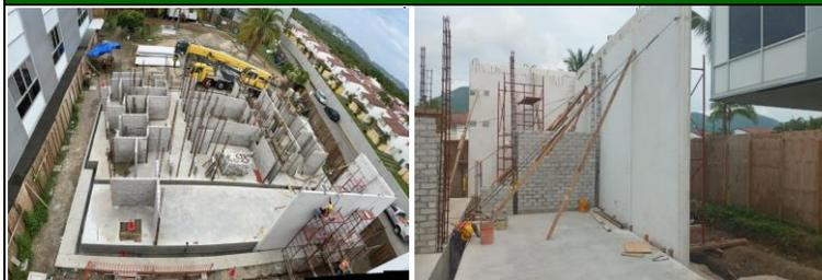
Panoramica Centro de Mezclas lado poniente Montaje de muros MPB001 (4 cuerpos) eje A, MPS001 (1 cuerpo) y MPS003 (1 cuerpo) eje 6.
