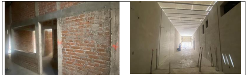
Albañilerías, muros de tabique, traves y castillos
