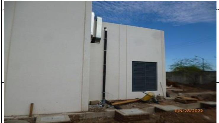
FACHADA ORIENTE CON BAJADA PLUVIAL Y PUERTA TIPO LOUVER EN TABLEROS ELECTRICOS
