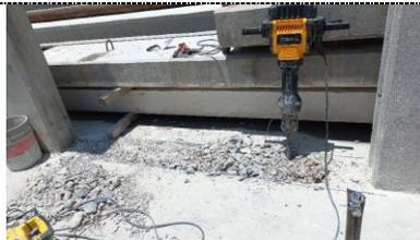
**DEMOLICIÓN DE PARTE INFERIOR DE MURO No. 13, UBICADO EN EL EJE B**
