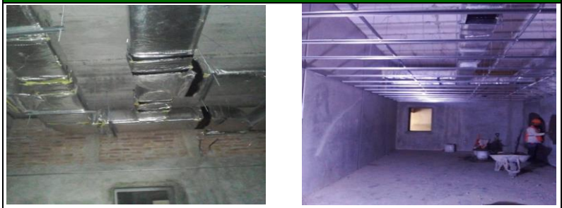
sum y coloc. Ductos
