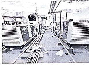
APLICACION DE SEGUNDA MANO TUBERIA CONDUIT.
