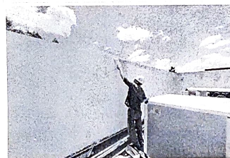
APLICACION DE PINTURA VINILICA EN PRETIL.
