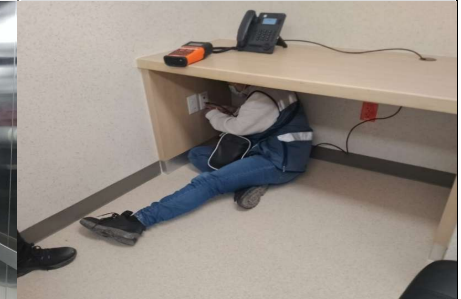
Colocación de tapas en salidas.
