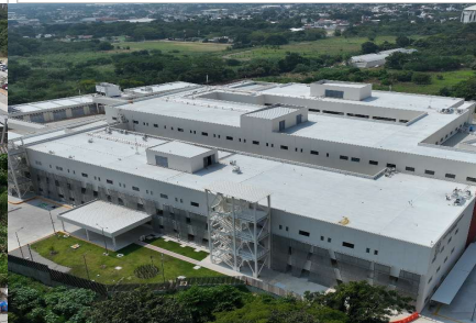
Limpieza fina de la obra.
