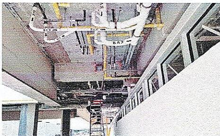
COLOCACIÓN DE FORRO, MANTA Y PINTURA EN TUBERÍAS DE AGUA CALIENTE PARA SERVICIO A TOCOCIRUGÍA DE NIVEL 1
