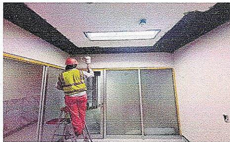
COLOCACIÓN DE PASTA EN MUROS, ÁREA DE JEFE DE SERVICIO DE IMAGENOLOGÍA, PLANTA BAJA
