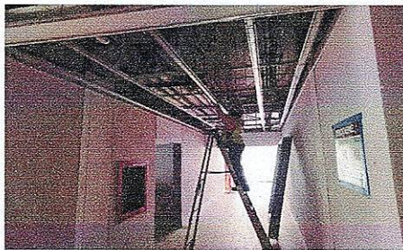
COLOCACIÓN DE FORRO EN DUCTOS DE INYECCIÓN DE HVAC, PASILLOS DE LAVANDERÍA EDIF. 4 P.B.
