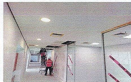
COLOCACIÓN DE DIFUSORES EN PASILLO DE HOSPITALIZACIÓN DE CIRUGÍA, EDIFICIO 6 NIVEL 2
