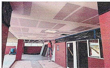
TRABAJOS DE LIJADO Y CALAFATEO DE PLAFONES DE TABLAMENTO EN ÁREA DE LAVANDERÍA PLANTA BAJA
