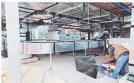
HABILITADO Y MONTAJE DE DUCTOS DE LÁMINA GALVANIZADA PARA INYECCIÓN Y RETORNO HVAC, AZOTEA CTO. DE EQUIPOS No. 6
