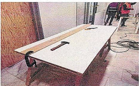
HABILITADO Y COLOCACIÓN DE PUERTAS CON CAPA DE PLOMO PARA ÁREA DE IMAGENOLOGÍA, PLANATA BAJA
