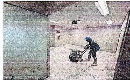
DESBASTE Y PULIDO DE PISO DE MÁRMOL, OFICINA DE APOYO ADMINISTRATIVO, PLANTA BAJA
