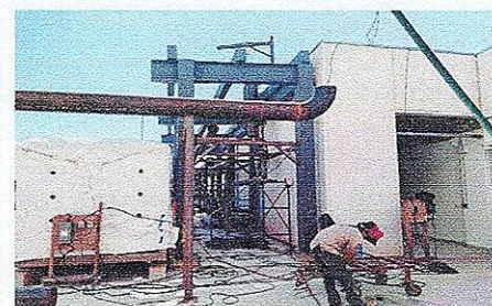
HABILITADO, MONTAJE Y SOLDADURA DE TUBERÍA Y CONEXIONES DE ACERO AL CARBÓN, CTO. DE BOMBAS CHILLERS
