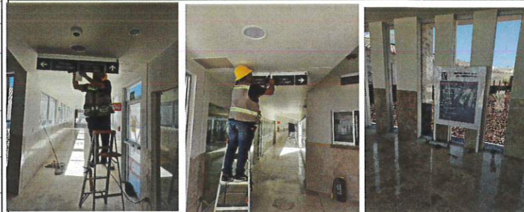
INSTALACION DE SEÑALIZACIONES GANERALES EN TODO EL HOSPITAL
