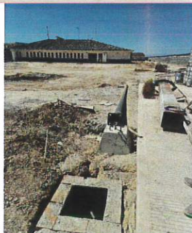
Instalacion de Luminarias faltantes en area PTAR
