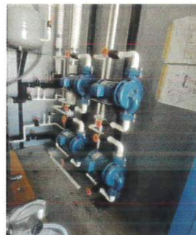
Instalacion de Bombas recirculadoras de agua caliente
