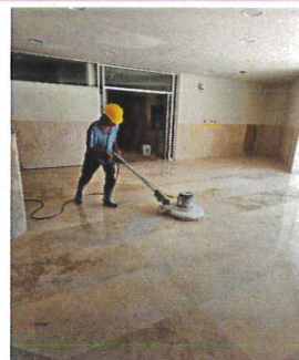
Pulido de Marmol edificio "B" área pasillos
