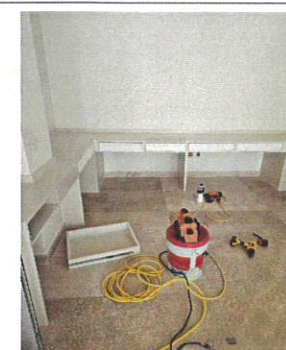
Fabricacion de mesa de trabajo en area de residencias
