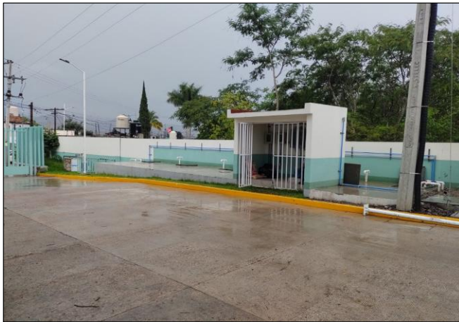
Planta de Tratamiento de Aguas Residuales
