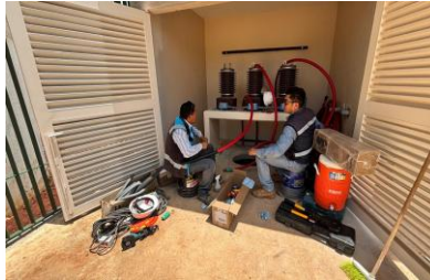
Cableado y conexión de subestación receptora y
