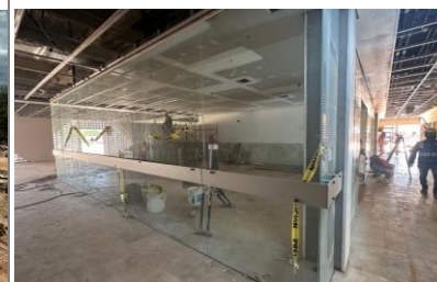
Colocación de protección para camillas en canceleria.
