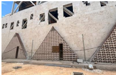
Preparación para cable de sistema de tierras.
