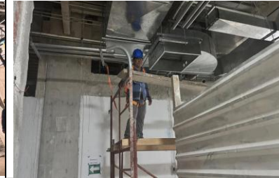
Montaje de tubería para sistema de fibra óptica.
