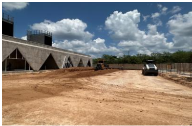
Trabajos de terracerías obra exterior.
