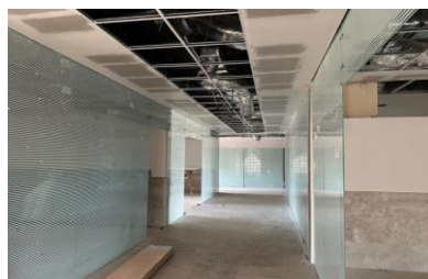
Colocación de canceleria en Medicina Física.
