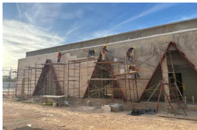
Colocación de cantera en fachada de casa de máquinas.
