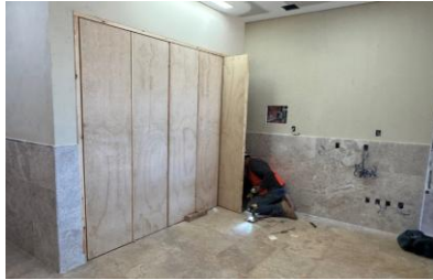
Colocacion de closet en Urgencias.
