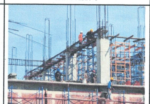
HABILITADO Y ARMADO DE TRABES N-2 EDIF. "C"
