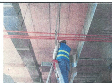
COLOCACIÓN DE SOPORTERÍA PARA TUBERÍA SANITARIA N-2 EDIF. "B"
