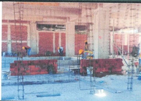
DESPLANTE DE MUROS DE TABIQUE ROJO PB EDIF. "E"
