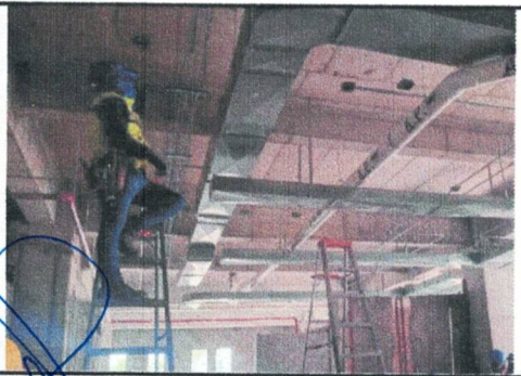
COLOCACIÓN DE SOPORTERÍA PARA CONTACTOS N-2 EDIF. "A"
