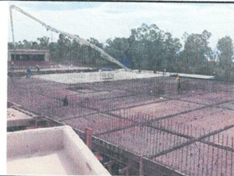
COLADO DE LOSA AZOTEA EDIF. "E"
