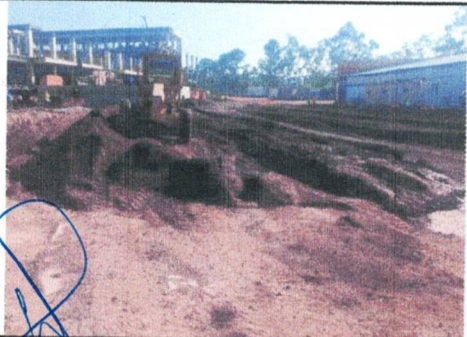
MEJORAMIENTO DE TERRENO DE ESTACIONAMIENTO PERSONAL
