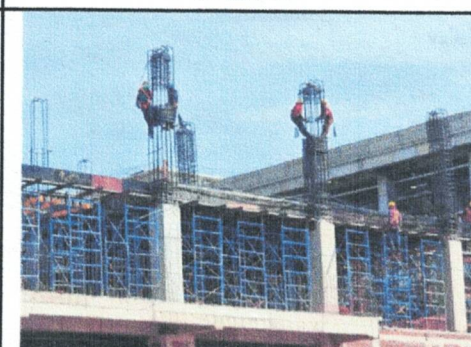
HABILITADO Y ARMADO DE COLUMNAS N-2 EDIF. "C"
