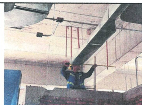
HABILITADO DE DUCTOS N-3 EDIF. "B"
