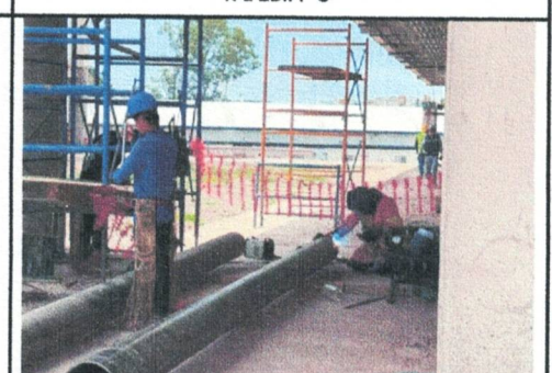
HABILITADO DE TUBERÍA DE AGUA HELADA PB EDIF. "D"
