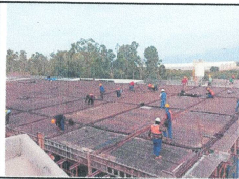
HABILITADO Y ARMADO DE PARRILLA AZOTEA EDIF. "E"
