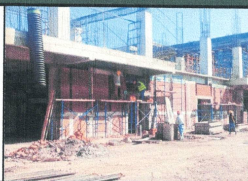
DESPLANTE DE MUROS DE TABIQUE ROJO PB EDIF. "C"
