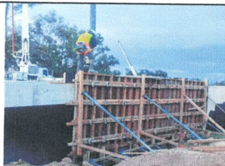
COLADO DE MURO DE CONTENCIÓN MC-2
