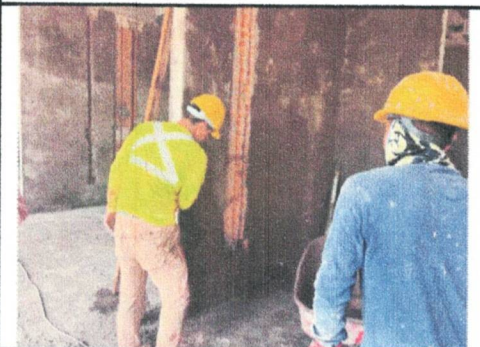
REPELLADO DE MUROS N-1 EDIF. "A"
