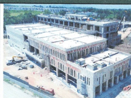
COLOCACIÓN DE CANTERA EN FACHADA NOROESTE Y NORPONIENTE EDIF. "A"
