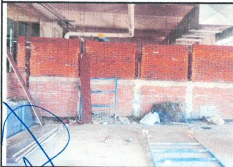
DESPLANTE DE MUROS DE TABIQUE ROJO N-3 EDIF. "B"
