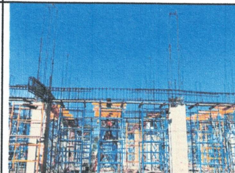
COLOCACIÓN DE CIMBRA PARA LOSA N-2 EDIF. "C"
