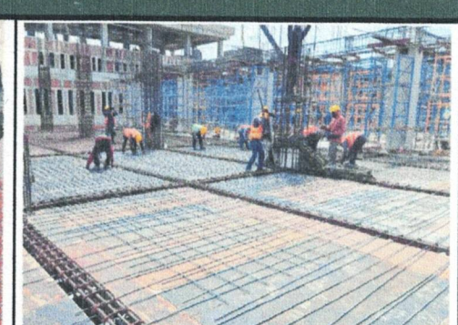
ARMADO DE PARRILLA PARA LOSA N-1 EDIF. "C"
