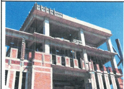
DESPLANTE DE MUROS DE TABIQUE ROJO EN FACHADA N-2 EDIF. "B"
