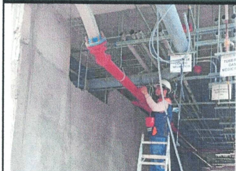
APLICACIÓN DE PINTURA EN TUBERÍA DE PCI PB EDIF. "B"
