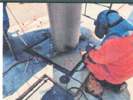
SOLDADURA DE COLUMNAS EN PLACA BASE VESTÍBULO PRINCIPAL
