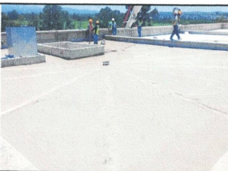
COLADO DE RELLENO FLUIDO EN LOSA DE AZOTEA EDIF. "A"
