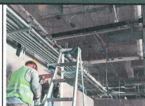
SELLADO DE JUNTAS DE DUCTOS PARA AIRE ACONDICIONADO N-1 EDIF. "A"
