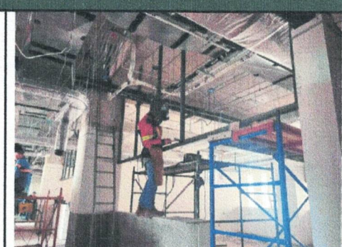
SOLDADURA DE BASTIDOR DE HERRERÍA PARA FALDONES PB EDIF. "A"
