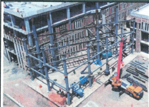
IZAJE Y MONTAJE DE VIGAS METÁLICAS VESTÍBULO PRINCIPAL
