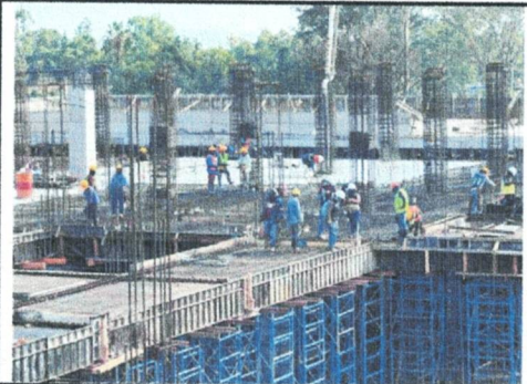
COLADO DE LOSA N-1 EDIF. "C"
