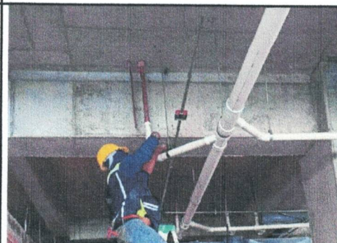
CANALIZACIÓN DE TUBERÍA DE INSTALACIÓN SANITARIA PB EDIF. "D"
