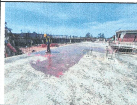
CURADO DE LOSA AZOTEA EDIF. "E"
