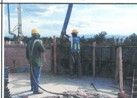
COLADO DE PRETIL AZOTEA EDIF. "B"
