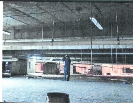
CANALIZACIÓN DE TUBERÍA SANITARIA SEMISÓTANO EDIF. "E"
