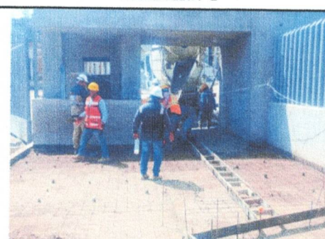
COLADO DE BANQUETA EN CASETA DE VIGILANCIA 02
