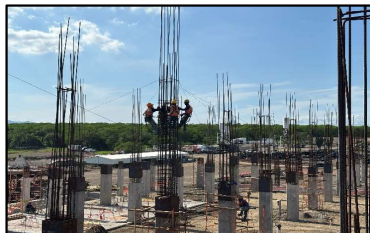
Trabajos de habilitado de acero en columnas de nivel 2 en edificio "A".
