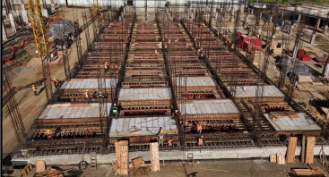
Trabajos de habilitado de cimbra y acero para losa de entrepiso en edificio "D2".
