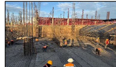
Trabajos de habilitado de acero para cisternas y cuartos de equipos del edificio "G".
