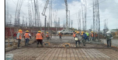
Trabajo de colado de losa de entrepiso de estacionamiento (rampa) en edificio "D2".
