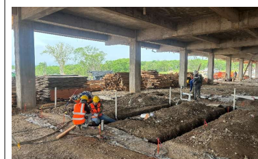
Trabajos de colocación de tubería sanitaria en edificio "B".
