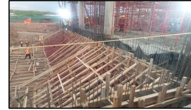
Trabajos de habilitado de acero y cimbra en muro de contención "MC-A" en cuarto de equipos 2, de edificio
