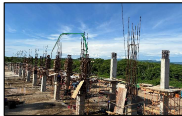
Trabajos de cimbrado y colado de columnas de segundo nivel edificio "A".
