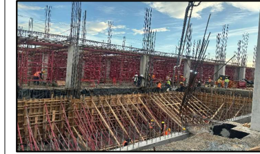
Trabajos de colado de muro de contención "MC-A" en cuarto de equipos 2, de edificio "D1".
