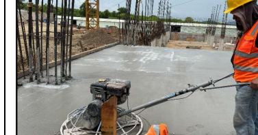
Trabajo de acabado pulido en colado de losa de entrepiso en edificio "D2".
