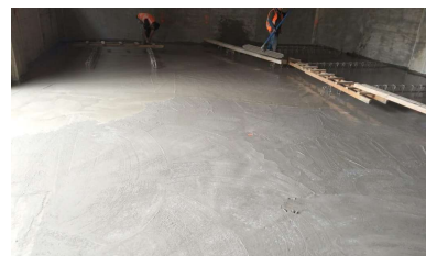
Trabajos de acabado pulido en colado en firme de losa de equipos de edificio "A".
