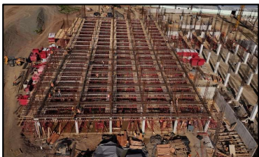
Trabajos de habilitado de acero de traves de la losa de entrepiso del primer nivel del edificio "E".
