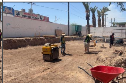
Compactación de terreno natural.
