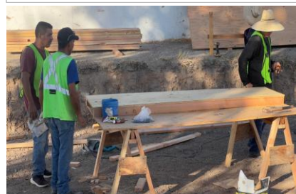
Habilitado de cimbra para contratraves.
