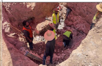
Demolición de estructura existente (cisterna).
