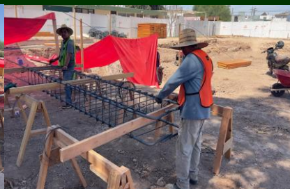
Habilitado de acero de refuerzo para contratraves.
