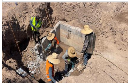
Demolición de estructura existente (cisterna).
