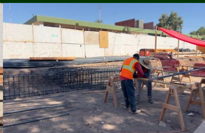
Habilitado de acero de refuerzo para contratraves.
