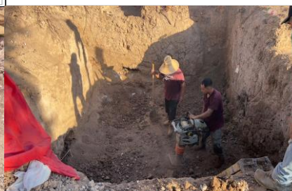
Compactación y relleno en área de estructura existente.
