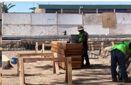
Habilitado de cimbra para contratraves.
