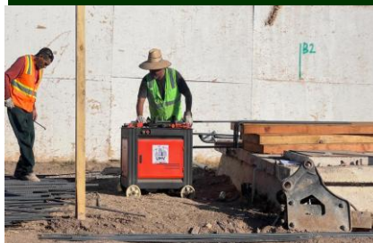
Doblado de acero de refuerzo para contratraves.
