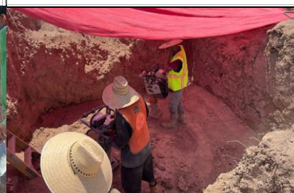
Excavación para cimentación.
