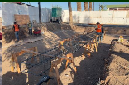
Habilitado de acero de refuerzo para contratraves.
