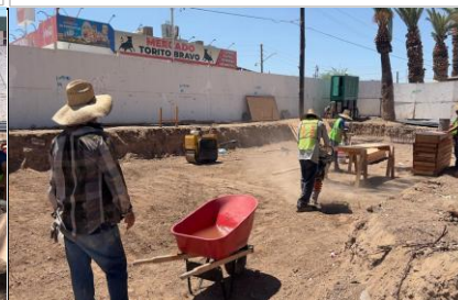
Compactación de terreno natural.
